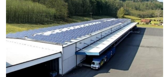
Installation industrielle PV sur toiture, 500 kWc Source: IBC Solar
